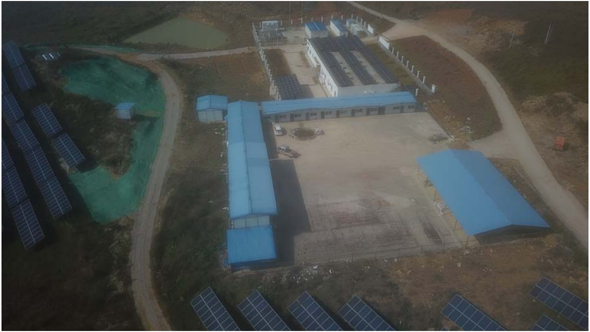
开闭站及施工生产区
